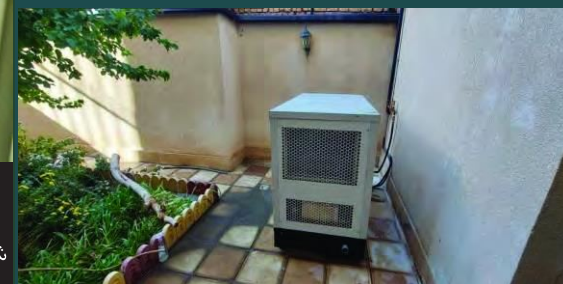
بانک تجارت شعبه شهرک صنعتی شمس اباد
